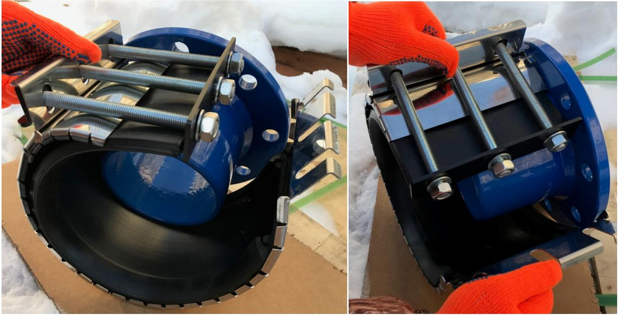
Дополнительно рекомендуется обработать по кругу трубы место фиксации уплотнительного элемента хомута: технический силикон, мастика и т.д. Дополнительная обработка места установки хомута позволит на трубах с высокой коррозией (пористостью), получить максимально возможную герметизацию и более равномерное распределение уплотнения по всей окружности трубы. Наличие сделанных отметок облегчит правильную установку хомута.
